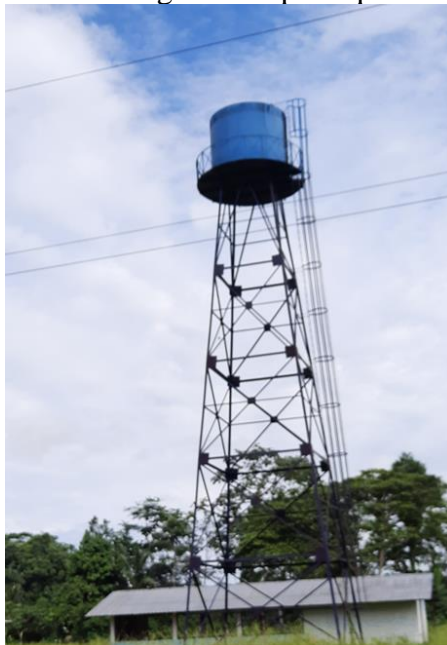
Fotografía 12. Sistema de agua de la parroquia Tres de Noviembre.
